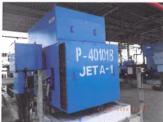
เครื่องสูบน้ำส่งน้ำมันไปยังสถานีรับน้ำมันอากาศยานสุวรรณภูมิ
