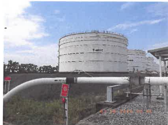
ระบบท่อส่งน้ำมันที่คลังน้ำมันลำลูกกาส่งน้ำมันไปยังสถานีรับน้ำมันอากาศยานสุวรรณภูมิ
